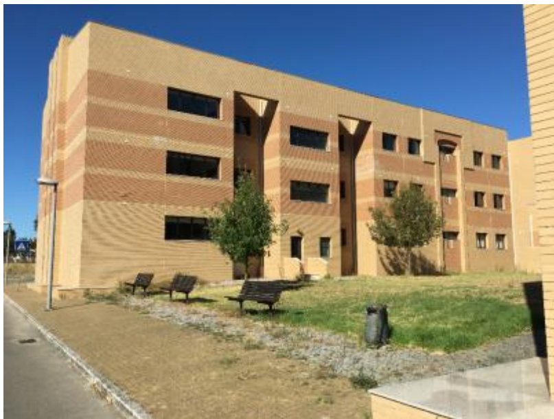
Figura A.5- Fotografia de uma fachada do edifício em análise.
