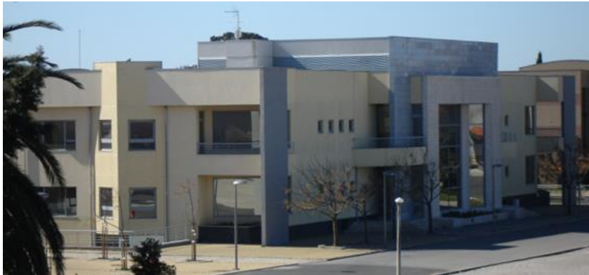
Figura 4.3- Edifício do aluno.
