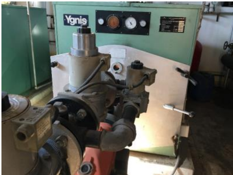
Figura 4.17- Caldeira de aquecimento Ygnis modelo NAR 320.
