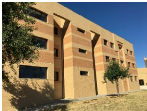
Figura 4.15- Fotografia do exterior do corpo de alojamentos em análise.
