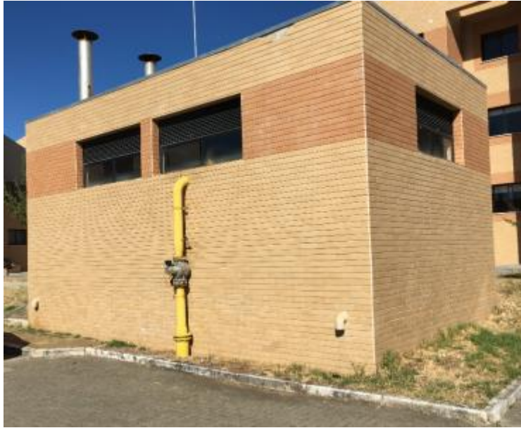
Figura 4.16- Edifício das caldeiras.
