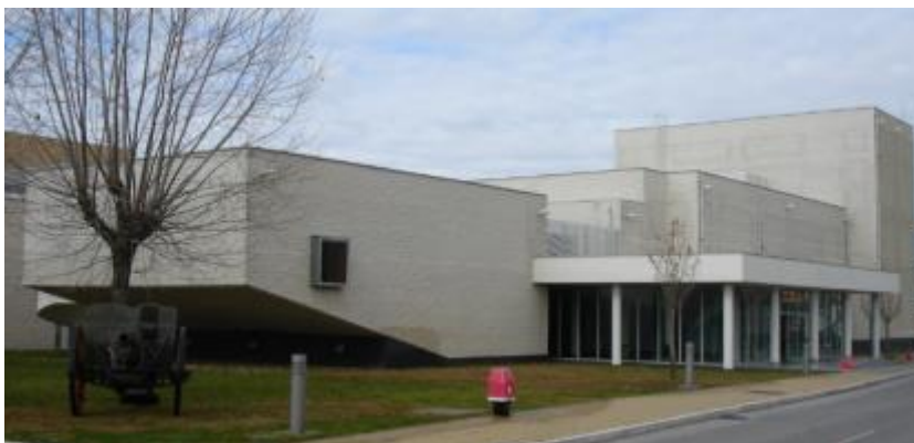
Figura 4.4- Edifício dos auditórios.
